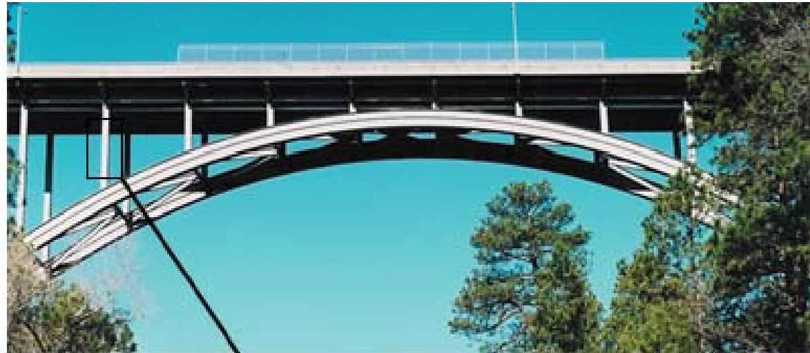
Canyon Bridge, Los Alamos, NM
