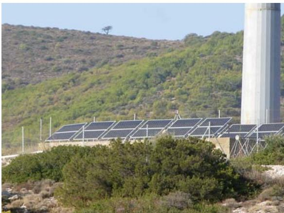
**Fig. 9.26** CRES 4 kWp PV unit
